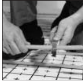
14. An der Lötstelle: Bei ummantelten Rohren den Mantel auf ca. 150 mm aufschlitzen und zurückklappen; Rohrenden außen und innen kalibrieren (siehe Bild 4).
