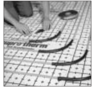
19. Auspolstern der Bögen am Außenradius bei geraden Längen über 5m. Nicht bei Gussasphalt.
