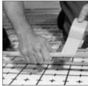
18. Nach Druckprobe Kunststoffmantel - sofern vorhanden - zurückklappen, Längs- und Querschlitze mit Klebeband umwickeln.
