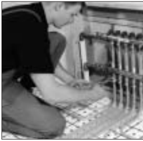
8. Einschieben des Rohrendes in das Ventil und am Heizkreisverteiler festschrauben (mit zwei Schlüsseln).
