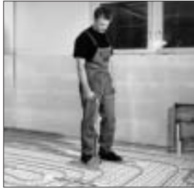
13. Beim Ansetzen eines neuen Ringes erfolgt zuerst wieder der Anschluß am Verteiler. Das Heizungsrohr wird vom Verteiler zur Lötstelle hin verlegt. Abschließend wird wie unter Punkte 4 - 12 verfahren.
