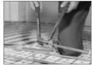
15. Handwerkliches Herstellen einer Lötuffe mit Expandergerät - alternativ: Lötuffe.
