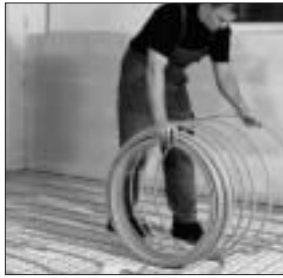
9. Ausrollen der Rohre entlang der aufgedruckten Rasterung nach Verlegeplan.
