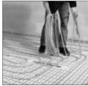
10. Biegen der 90°(bzw. 180°)-Bögen von Hand. Biegeradius größer oder gleich 15 cm, Knicke vermeiden.
