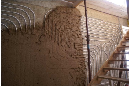
Abdecken der Rohrinstallation mit Lehmputz (li.) – und der fertig verputzte Innenraum (re.)
