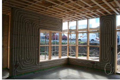
Die Rohrschlangen für die Wandheizung sind auf verzinkten Metallgittern befestigt. Die Basis des Aufbaus bilden Holzwoleplatten.
