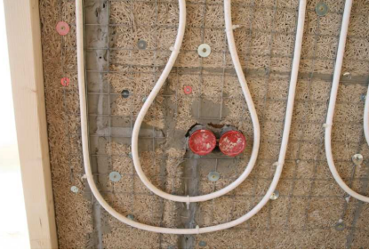
Die Rohrschlangen für die Wandheizung sind auf verzinkten Metallgittern befestigt. Die Basis des Aufbaus bilden Holzwoleplatten.
