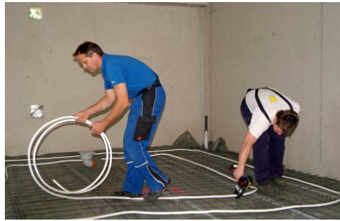
Insgesamt wurden 15.000 Meter Kupferrohr verlegt
