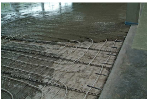
Einbringen des Betons - Nahaufnahme
