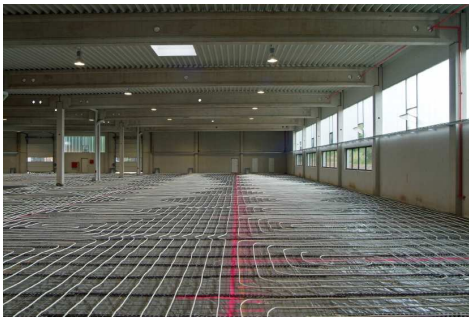
Die fertig verlegten CTX-Heizungsrohre
