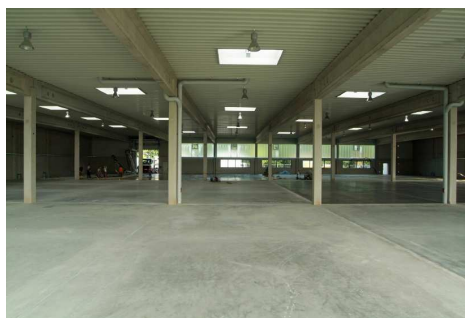
Der fertige Industriefußboden – mit integrierter Flächenheizung
