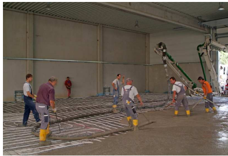
Einbringen des Betons nach der Verlegung
